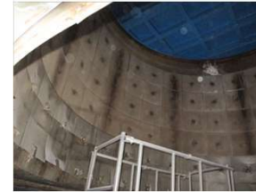
RETRAIT DES PROTECTIONS THERMIQUES DU PETIT BOUCHANT TOURNANT
